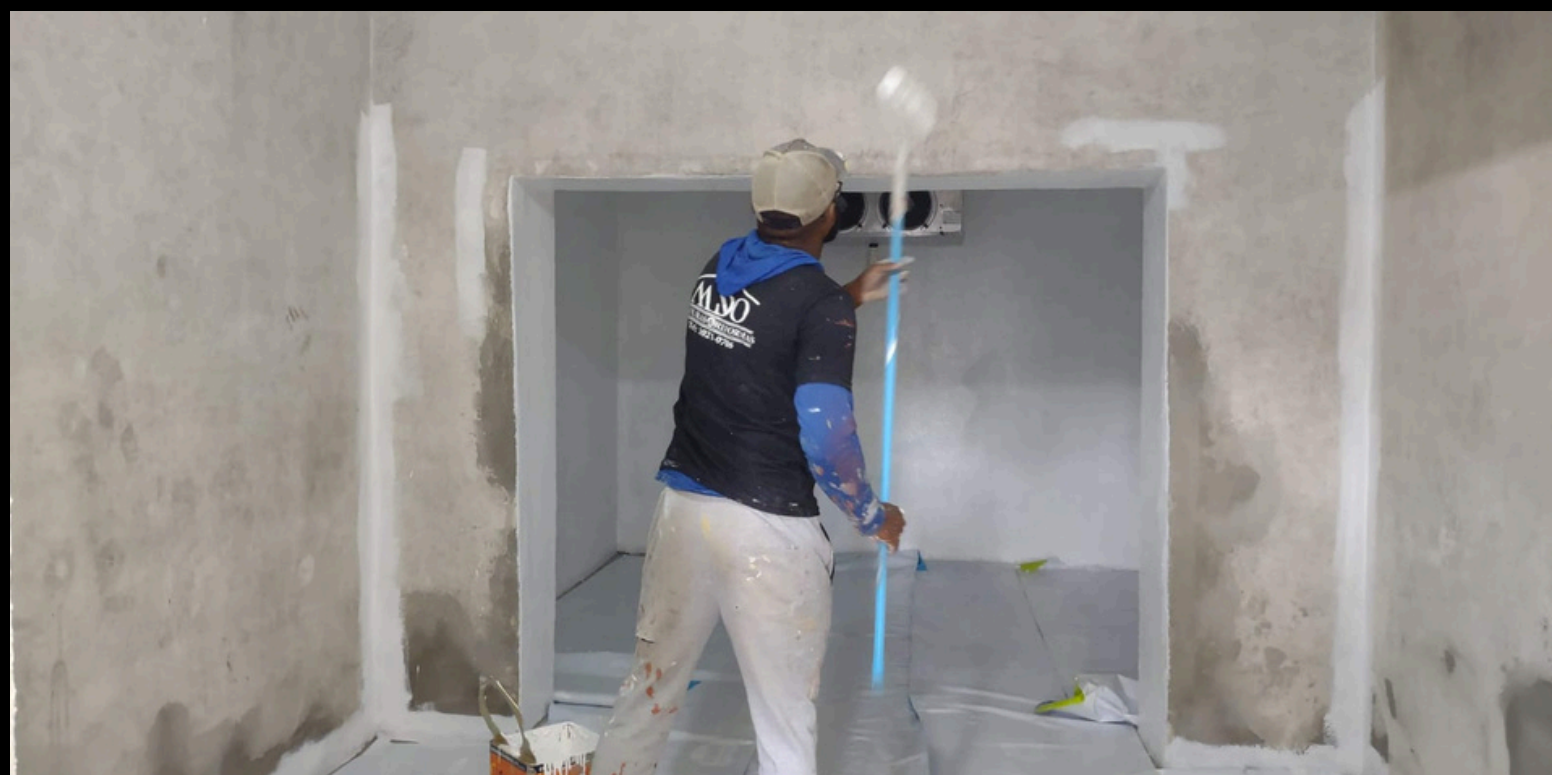
imagem referente a ipermiabilização de camera frigorifica
