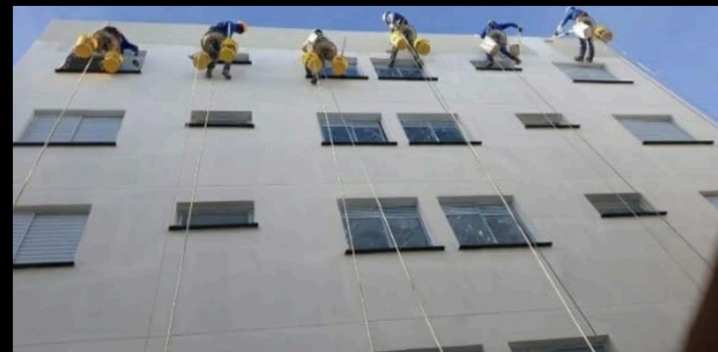
imagem referente a reforma e pintura de fachada de edificações
