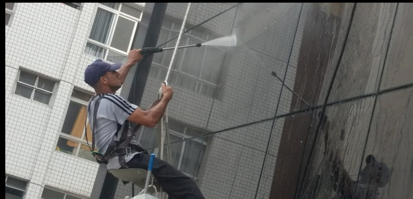
imagem referente a lavagem de fachada
