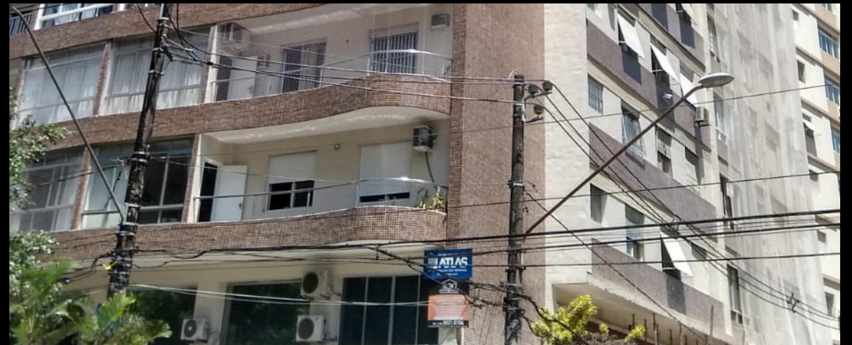
imagem referente a revestimento de fachada
