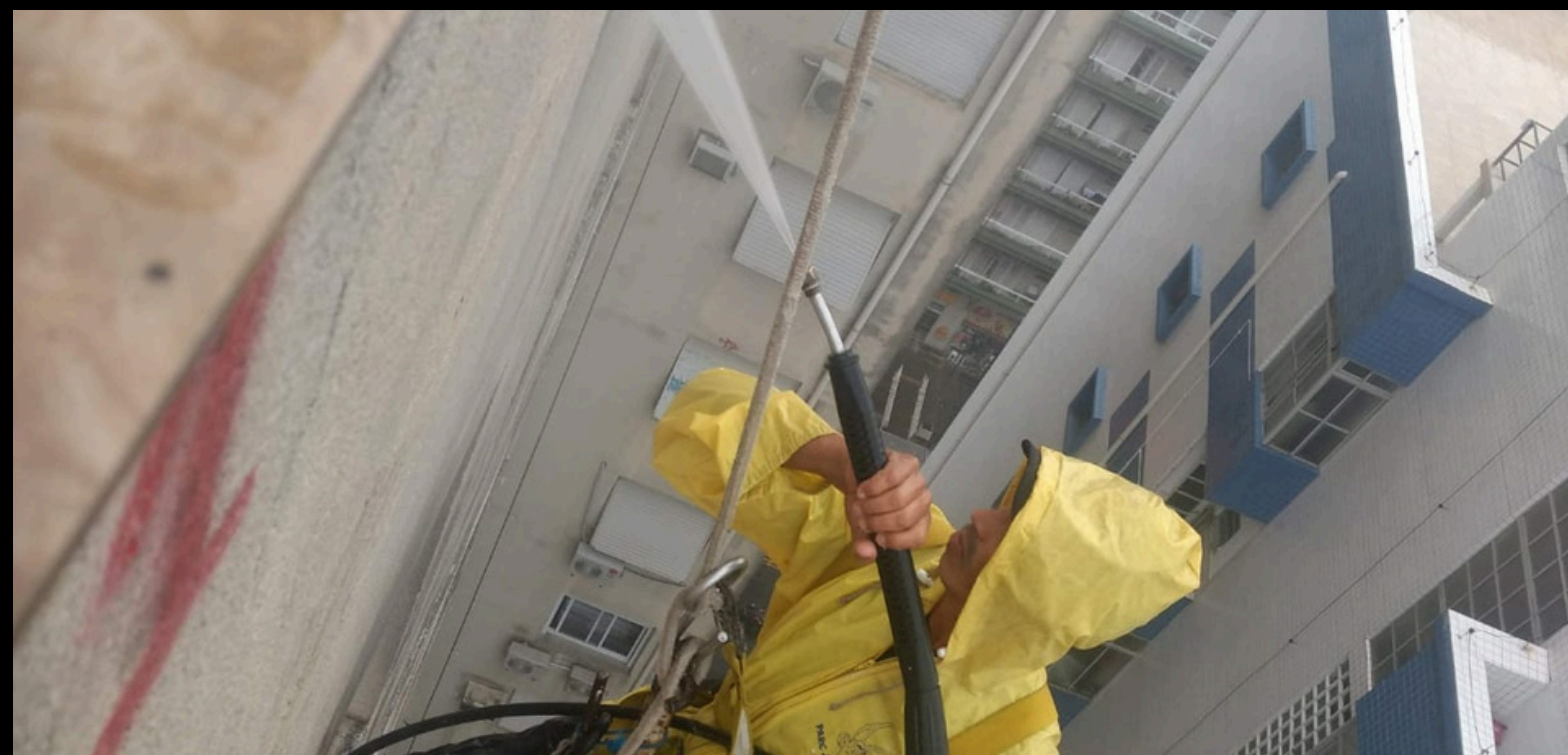
imagem referente a lavagem de fachada
