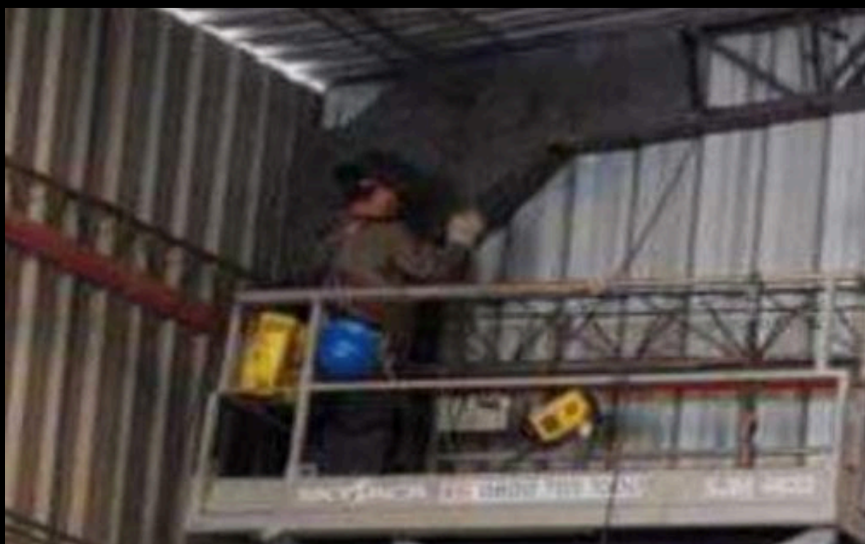
imagem referente a pintura de estruturas metálicas
