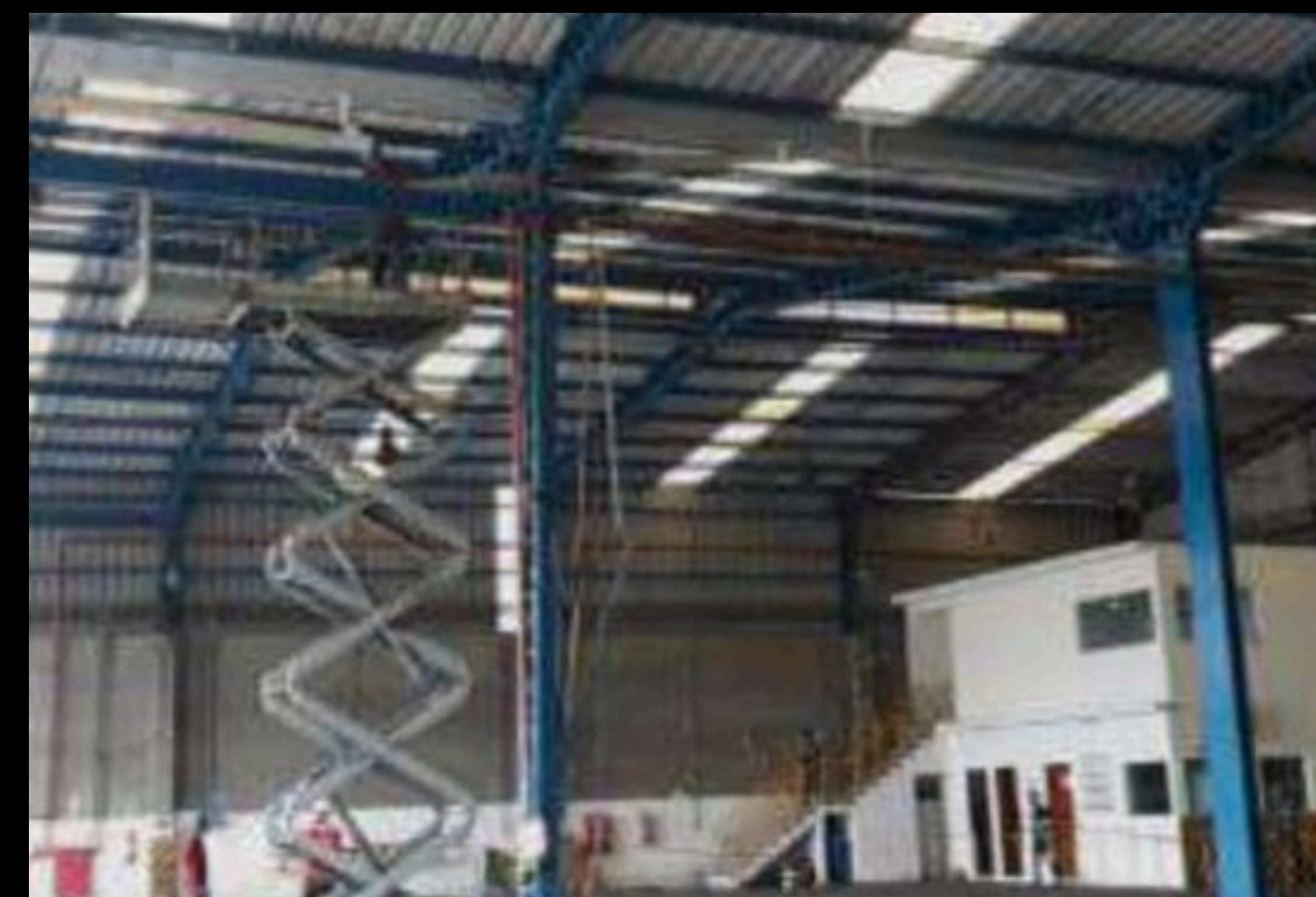
imagem referente a pintura de estruturas metálicas
