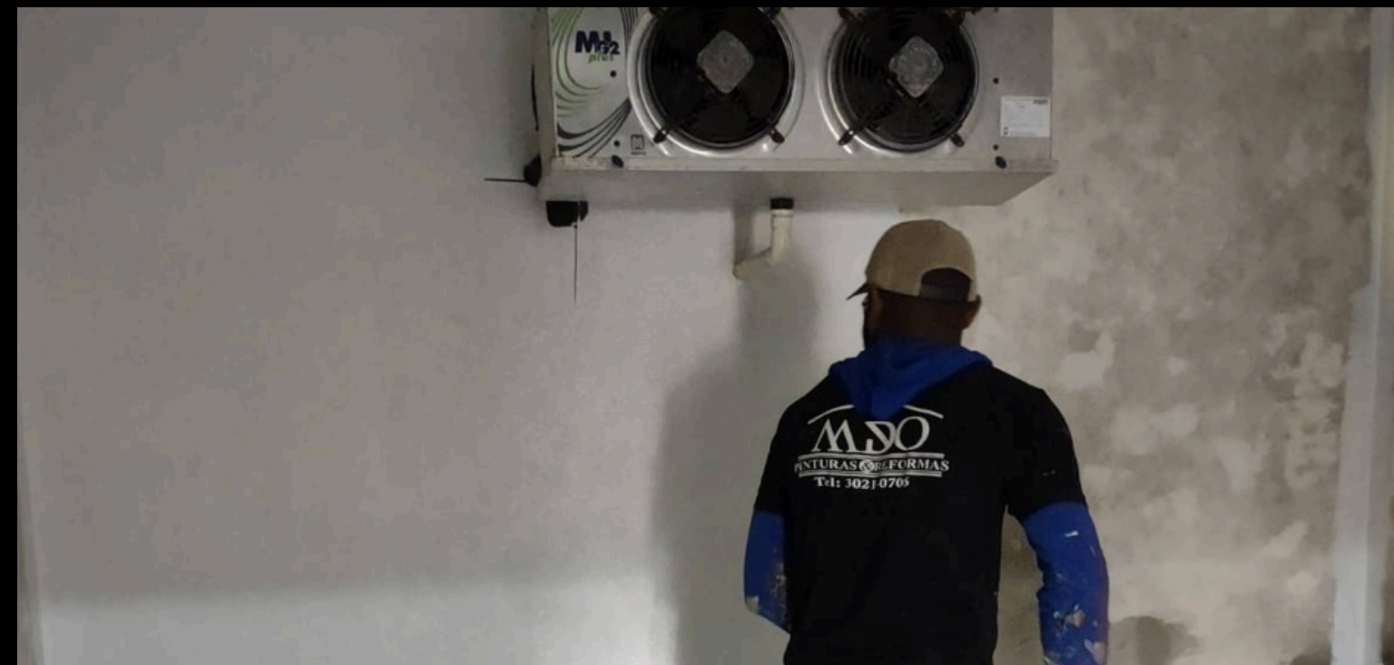
imagem referente a ipermiabilização de camera frigorifica
